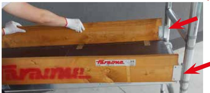
Coloque los rodapiés largos paralelamente a la plataforma de trabajo apoyando los finales de aluminio de los rodapiés contra el peldaño y contra el elemento portante bastidor de la torre (véase la fotografía de arriba).
