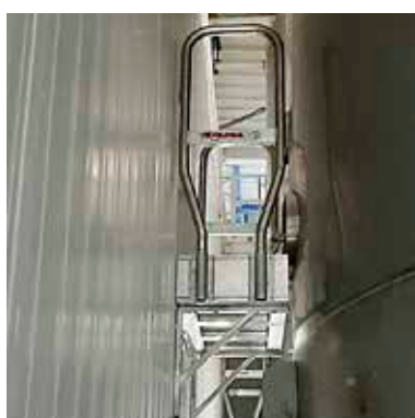
EM1114 Pasarela / Passadiço
