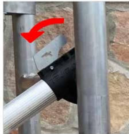
Durante la inserción del acoplamiento, el dispositivo de protección contra el desenganche accidental se cierra.
