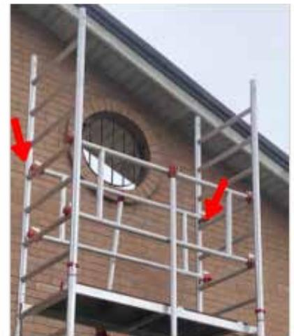
cerca posible del montante del lateral, apuntando los extremos abiertos de los ganchos hacia abajo en los peldaños del lateral y comprobando que el dispositivo de protección contra el desenganche accidental está colocado.
