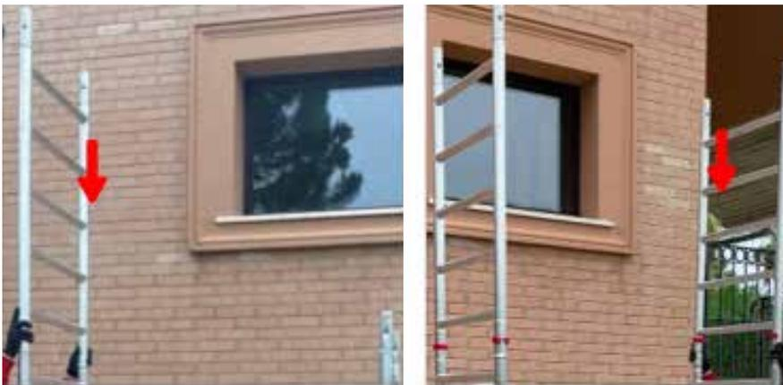
2) Coloque la plataforma en el **1º peldaño** de los laterales de 1,00 m, asegurándose de que el dispositivo de protección contra elevación accidental esté en la posición correcta.
