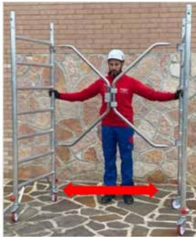
1) Coloque el módulo base en el lugar de trabajo definido y, con una mano en el lado izquierdo y la otra en el derecho, extienda el módulo base.
