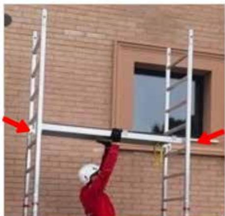
4) Inserte una diagonal comenzando en la parte superior del **2º peldaño [desde abajo]** del lateral de 2,00 m, en el lado opuesto a la diagonal colocada en el módulo inferior, teniendo cuidado de colocarse lo más cerca posible del poste del lateral.
