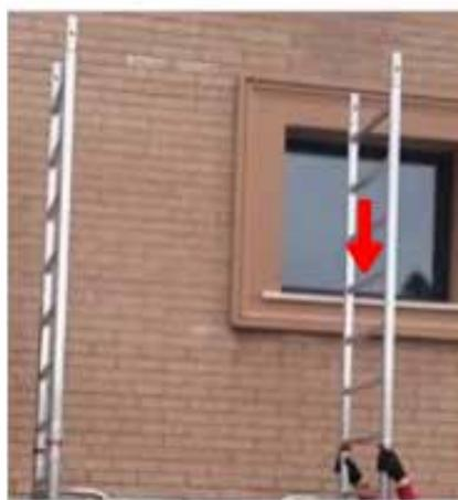
3) Enganche las dos barandillas con el soporte de montaje desde abajo y colóquelos, con el gancho superior en los lados longitudinales delantero y trasero en el **cuarto peldaño** (desde abajo) de los laterales de 2,00 m, asegurándose de que la barandilla contra el desenganche accidental esté en su sitio.
