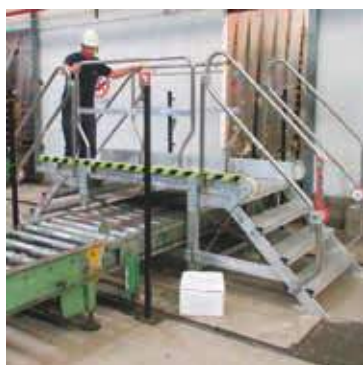
EM1108 Pasarela / Passadiço
