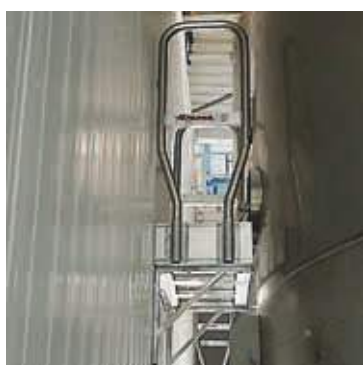
EM1114 Pasarela / Passadiço
